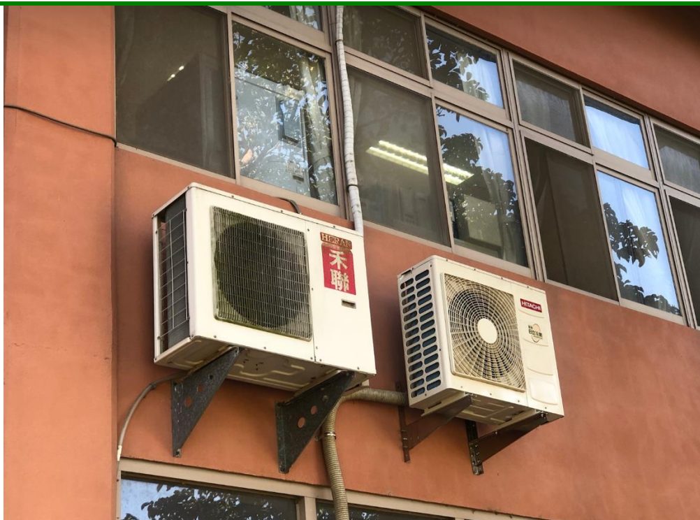
老舊耗能冷氣更換節能冷氣—教師辦公室
