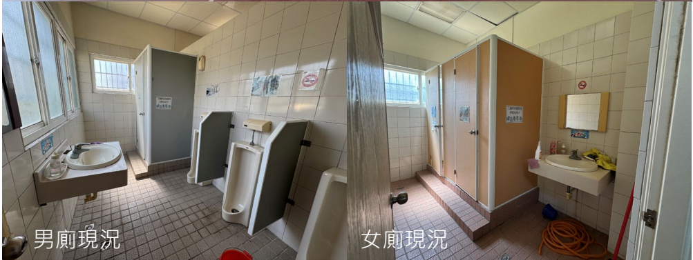
廁所入口現況
