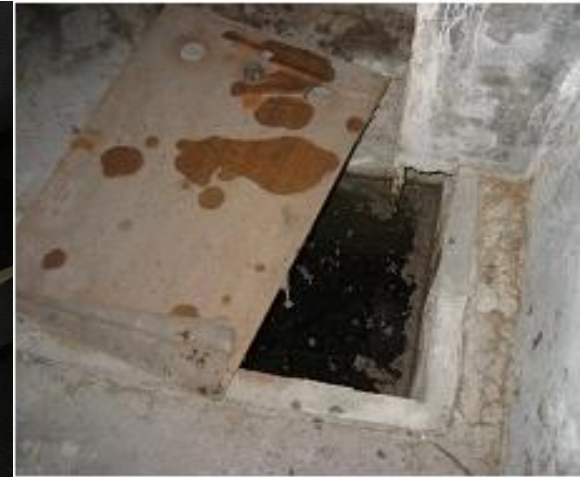
地下室污水池
