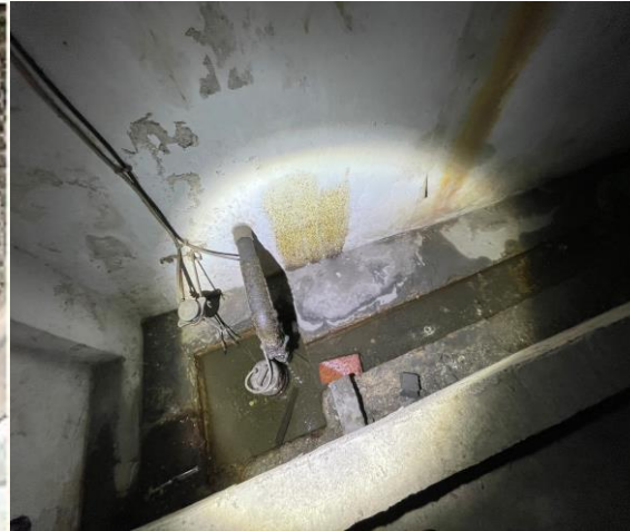
地下室集水井
