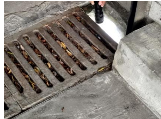
地下室車道水溝
