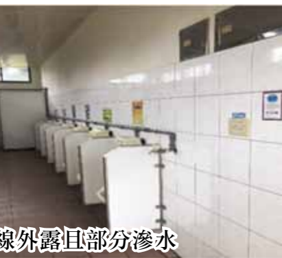
管線重新配置於壁面
