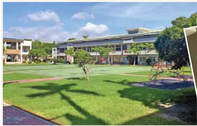
▲東棟及南棟校舍內庭
