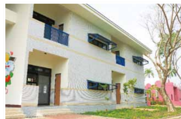
東側面以老師席、學習角及置物儲櫃小陽台組成，為融入綠建築遮陽的設計手法。
