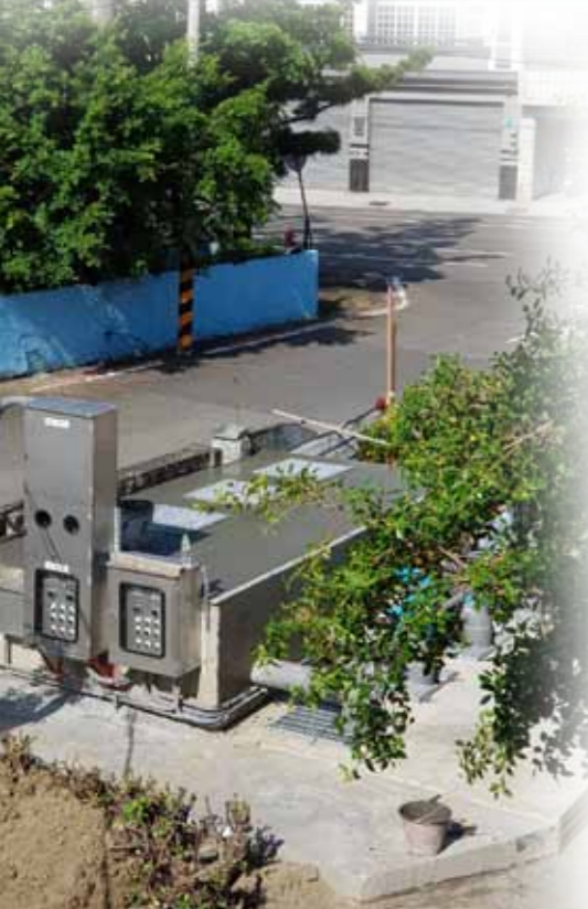
抽水站設備完工
